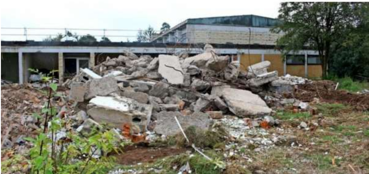
Das Haus Hohenwald wird abgerissen, vom zugehörigen Wohnhaus sind nur noch Reste übrig. Foto: Florian Lerchbacher
